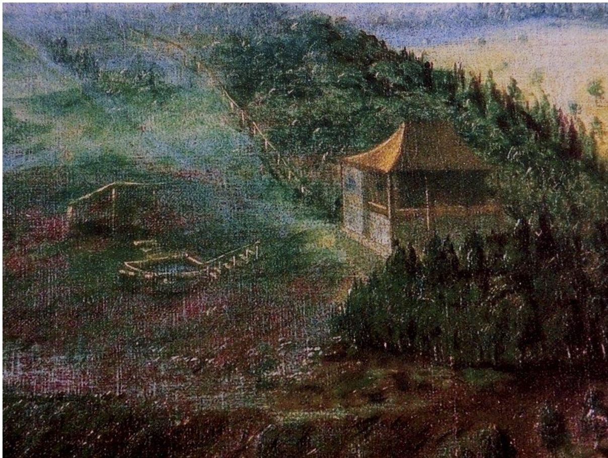
Obrázek 20: Nové Bon Repos – původní stav
