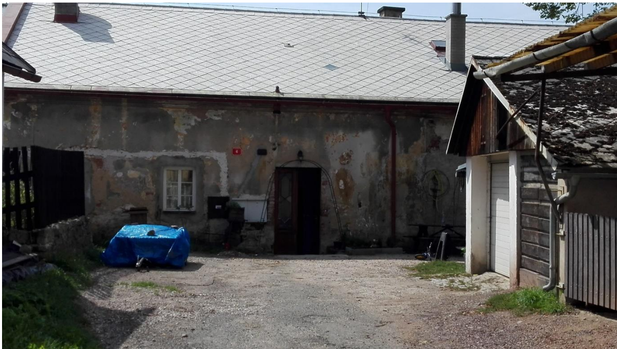
Obrázek 21: Objekt k bydlení č. p. 4 – stav k srpnu 2017
